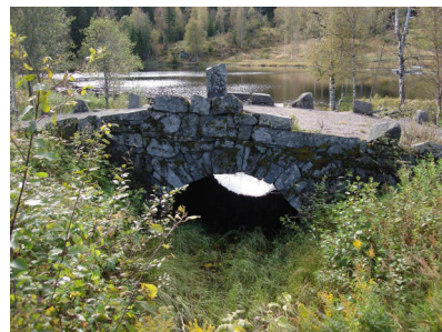
Amtsbroa, steinhvelvbro ved Langebrutjern
