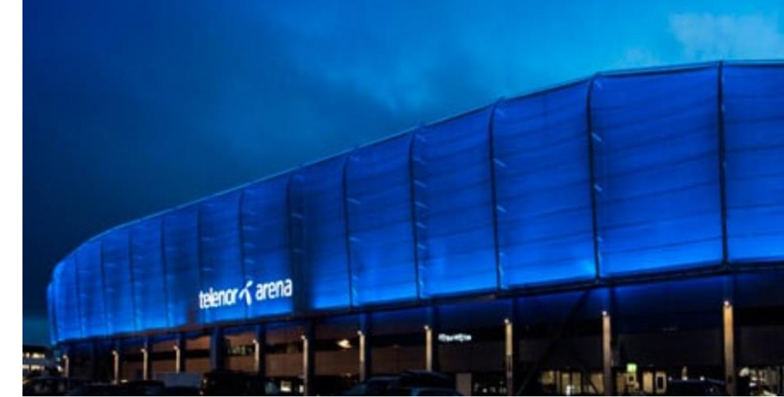
Opplyst fasade. Kilde: Ditt Fornebu
