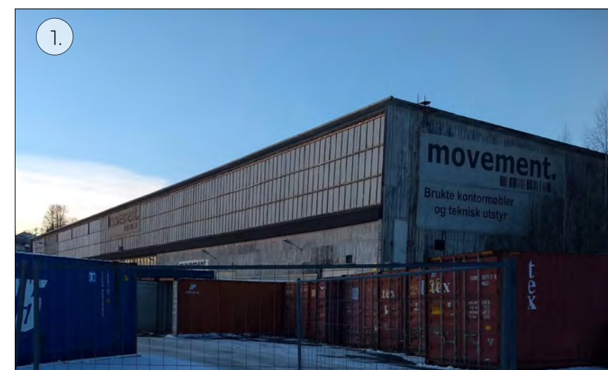
1. Hangar fra andre verdens krig. Ligger som en del av et kulturmiljø bestående av tyske hangarlegg fra årene mellom 1940 - 145. Bygget er Sefrak-registrert med nummer. 18518651.
