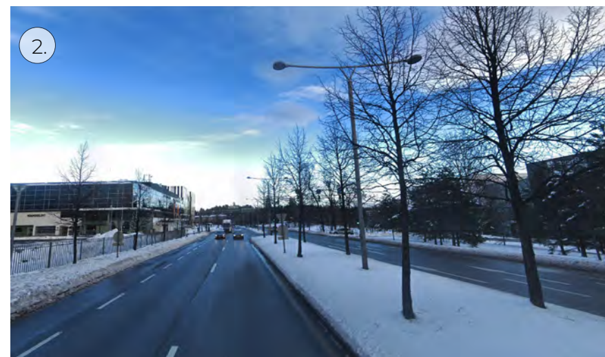
Snarøyveien er utformet på en måte som skaper en barrierevirkning for adkomst mot området mot Lysakerfjorden
