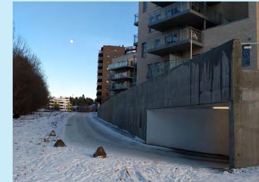
Boligsameiene har særs lukkede fasader ut mot Oksenhøyveien.
