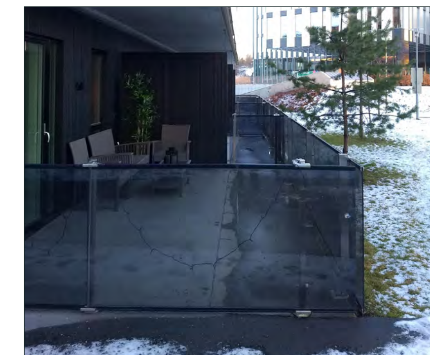
Opp mot Parkkorridoren er det anlagt markterrasser uten beplantningsmulighet
