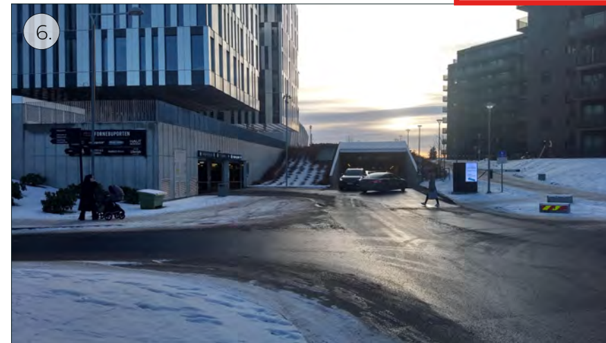
Nordøstre hjørnet av Fornebuporten: Nedkjørsel hvor det er problemer med trafikksikkerhet.
