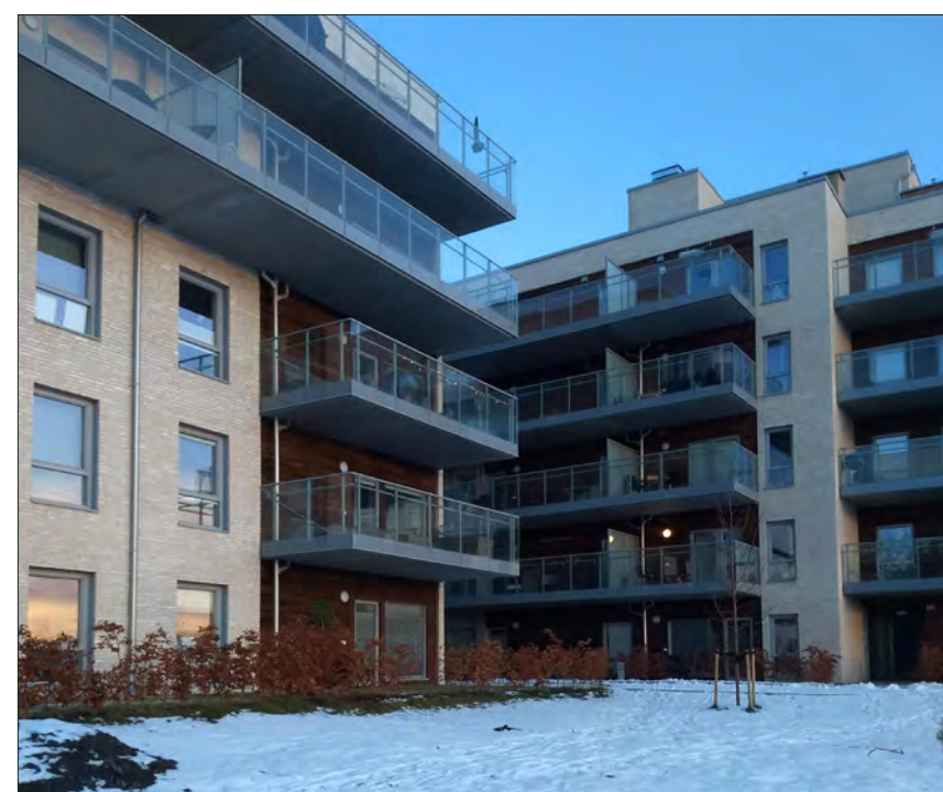
Byggene er utført i lys tegl med balkonger i stål og glass.
