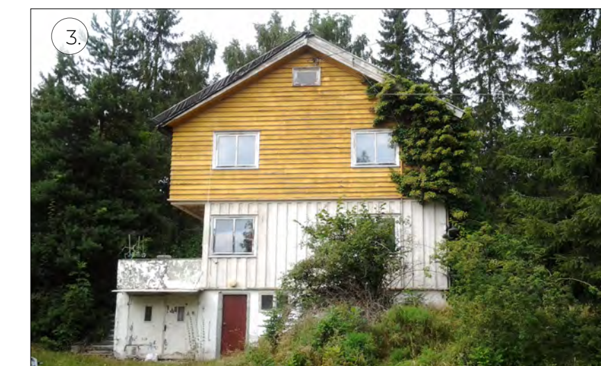
3. Kilenveien 85 Byggmesterfunkis med originale detaljer men i dårlig stand. Registrert som bygning oppført mellom 1920 - 1940.
