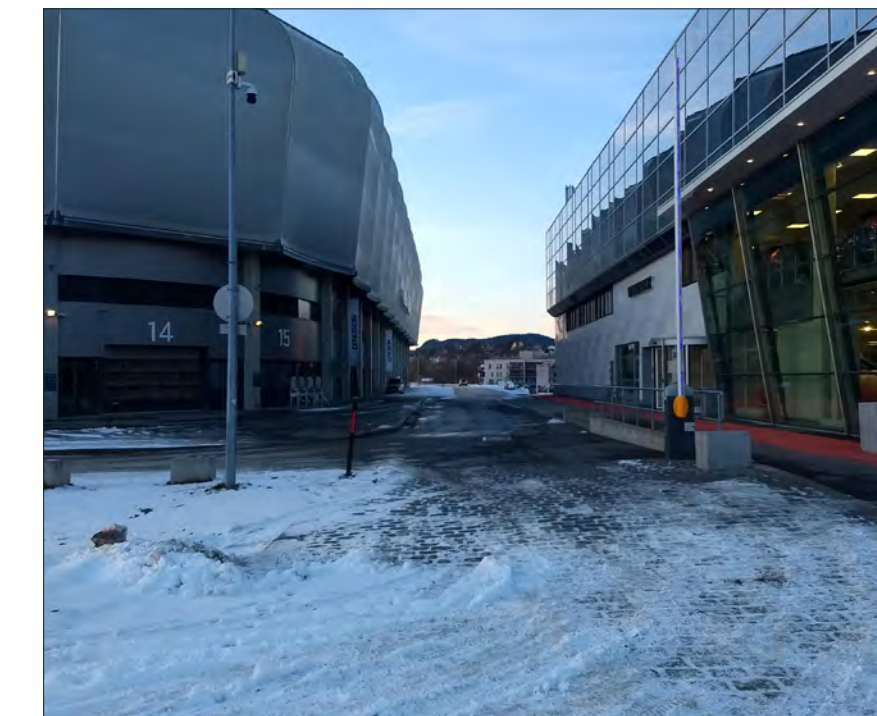
Trang situasjon mellom Telenor arena og Biliabygget
