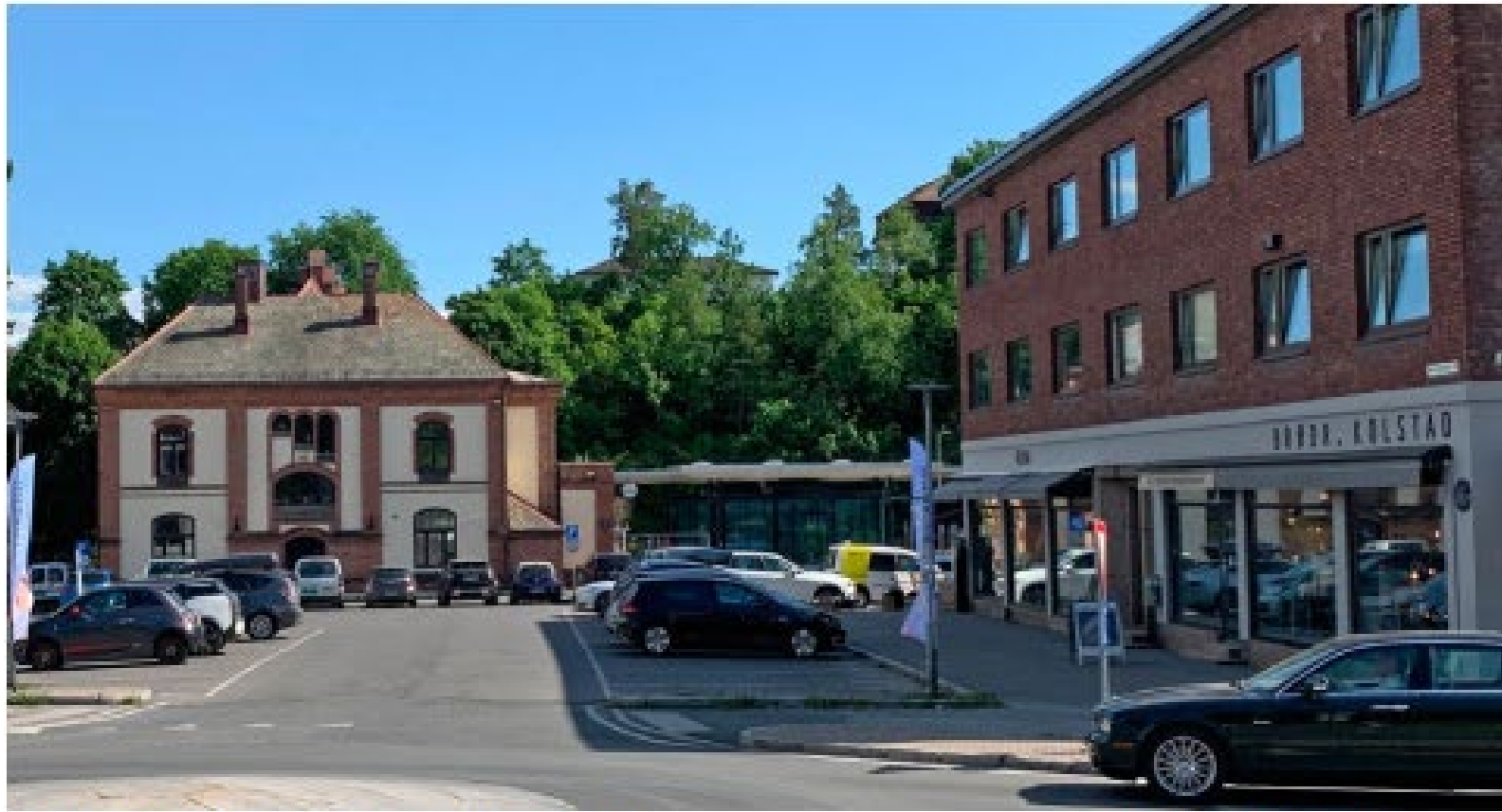
Stasjonstorget - Stabekkhuse og gamle stasjonen Eksisterende bebyggelse mange forbinder med Stabekk i dag er en murverden med brun tegl.
