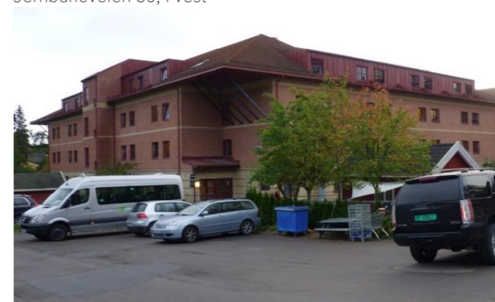
Jernbaneveien 35, i sør
