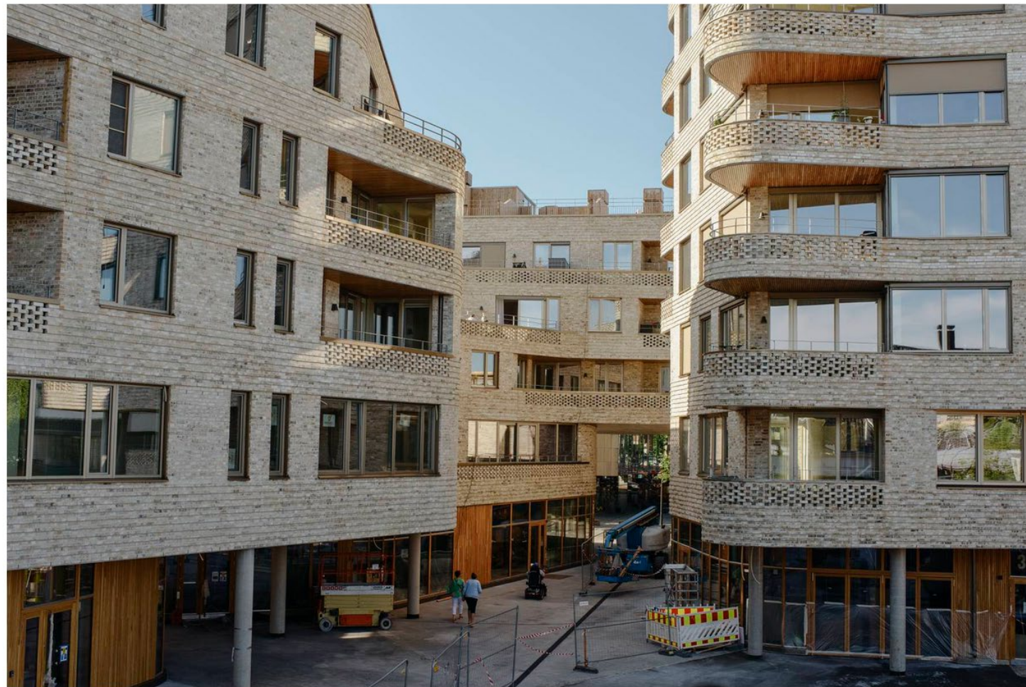
Tar tak i det som fantes: Det er ikke bare mange teglhus, men forbløffende mange teglhus med buede fasadedetaljer i Asker. Det har arkitektene grepet tak i med et nybygg med både særpreget og slektskap til omgivelsene. (Foto: Katinka Hustad/Foto: Katinka Hustad)
