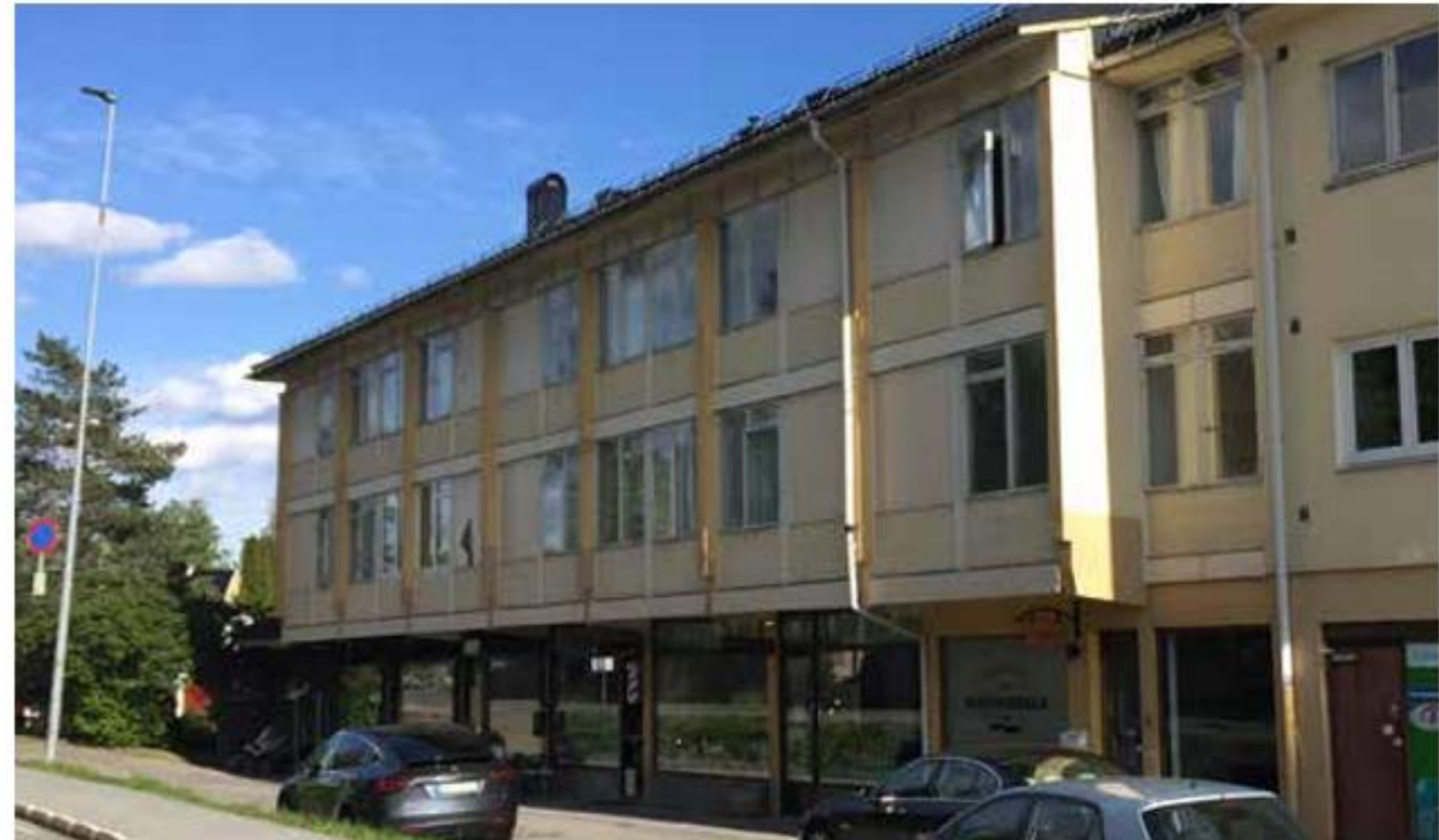
I 1955 ble det oppført et 2. byggetrinn på Haslumhuset, slik ser det ut i dag.
