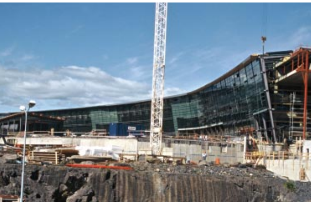
Bildet viser Telenors nybygg på Fornebu under oppførelse.
