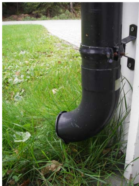
Frakoblede taknedløp kaster overvannet ut på plenen og reduserer tilførselen til avløpsnettet (foto B.C. Braskerud)
