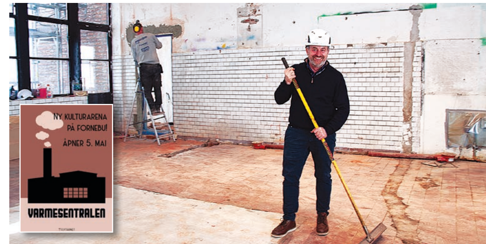
Daglig leder for Flytårnet Fornebu, Øyvind Brandt, gleder seg til å åpne den nye kulturarenaen i det gamle fyrhuset. Foto: Bærum kommune
