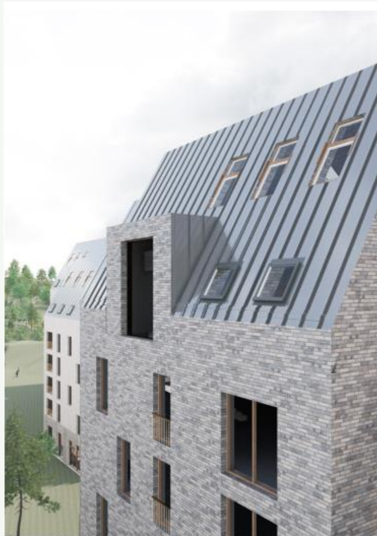
Eksempel: Takoppstikk med sink på tak
