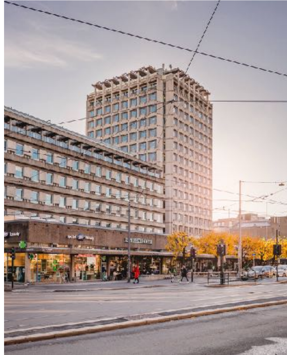
Indekshuset Henrik Ibsens gate 100 Oslo CBD
