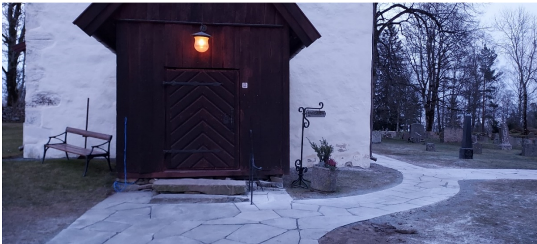
Reparasjon av skiferdekket foran hovedinngangen og på sydsiden av kirka ble godkjent og gjennomført 2021 Foto: Tone Israelsen
