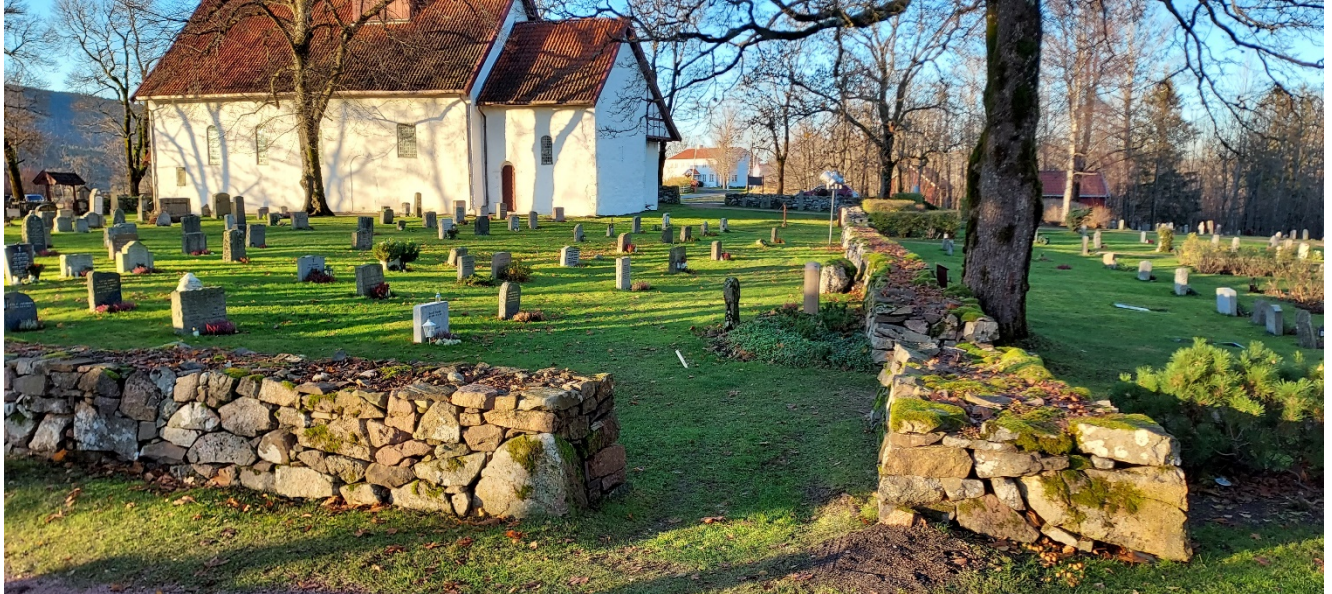
Bildet viser kirkegården sett fra sør i 2021. Steinmuren er ca. 1 meter høy og like tykk. Kjernen består av rydningsrøys. Steinmuren utgjør et habitat som leve- og skjulested for smågnagere og spissmus, muligens også piggsvin. Ekornet kan sannsynligvis legge en del vinteropplags- næring i muren. Enkelte fuglearter, som bl.a. rødstrupe og linerle, kan finne reirplasser der. Foto: Tone Israelsen
