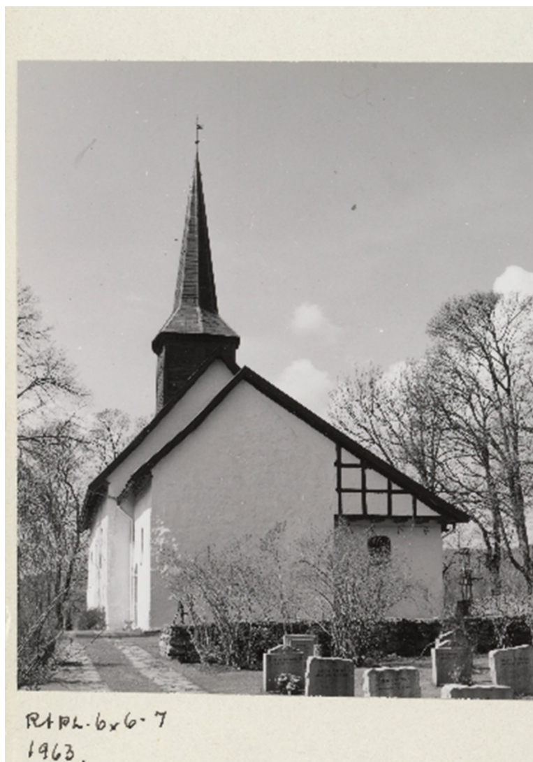
Prydbusker og skifegang med brede gressfuger fra parkeringsplassen i nord og østover, 1963. Kilde: Bærum bibliotek
