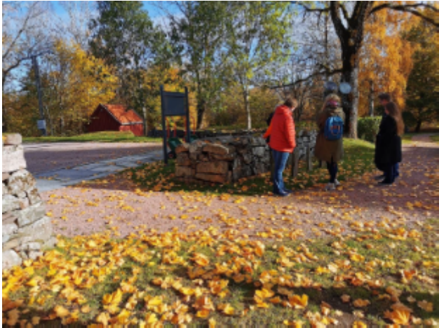
ÅPNING I MUREN, NORD FOR MIDDELALDERKIRKEGÅRDEN. PÅ DEN ENE SIDEN AV ÅPNINGEN ER MUREN LAVERE ENN PÅ DEN ANDRE. FYLKESKOMMUNEN MENER AT EN PORT SOM SETTES INN BØR FLUKTE MED LAVESTE MUR. © ANJA S. MELVÆR, VIKEN FYLKESKOMMUNE.
