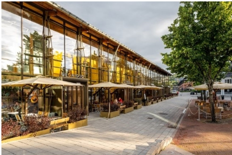
Asker Stasjon. Foto: Terje Borud, BaneNOR
