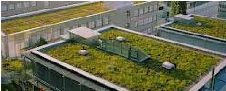
Eksempel på ekstensiv takhage, Stuttgart, Tyskland
