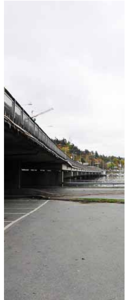
Dagens E18 går i bru sør for Sandvika sentrum øst. Foto: Bjørbekk & Lindheim
