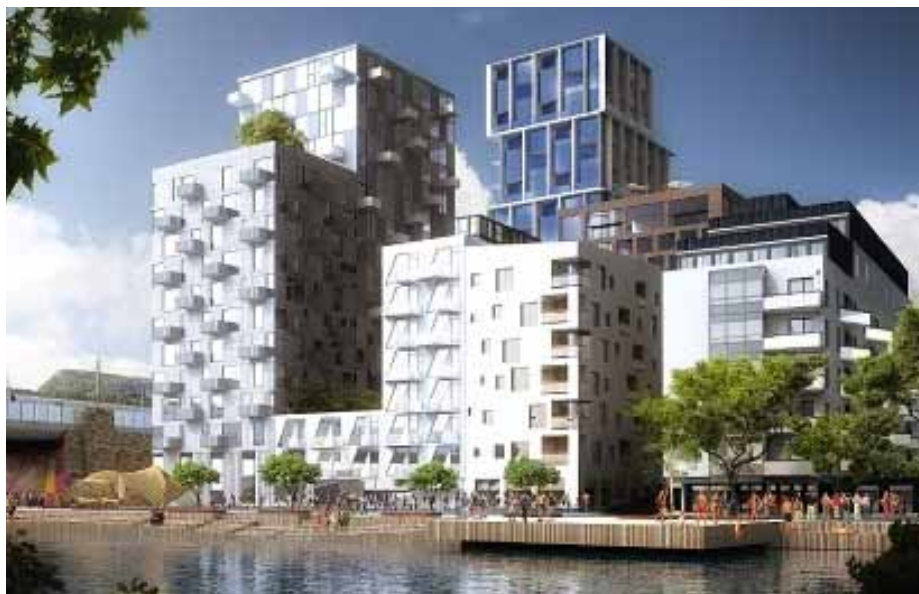
III: Andenæskvartalet. Perspektiv hentet fra "Bearbejdet versjon (...) etter innspill fra Bærum kommune", MAD arkitekter, november 2013
