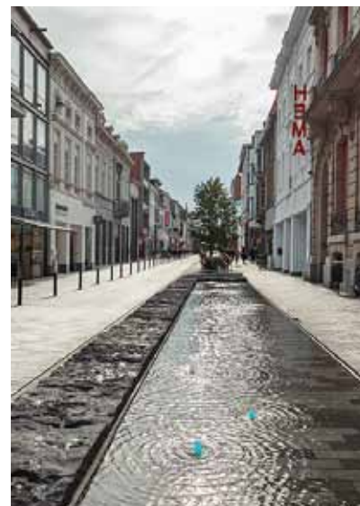
Vannelement i form av et vannspeil til både lek og rekreasjon. Remodelacion Stationsstraat, Belgia.
