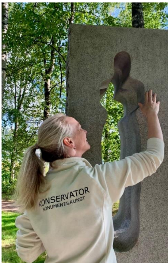
Tilstandsvurdering av 22. juli minnesmerket av Nico Widerberg.
